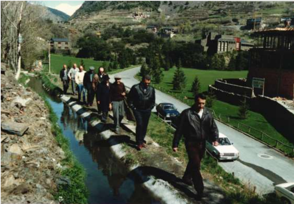
A la imatge -a l'altura de l'encreuament cap a la Massana- es pot apreciar com era el rec sense el passeig actual_Arxiu Comunal_21-04-1989
