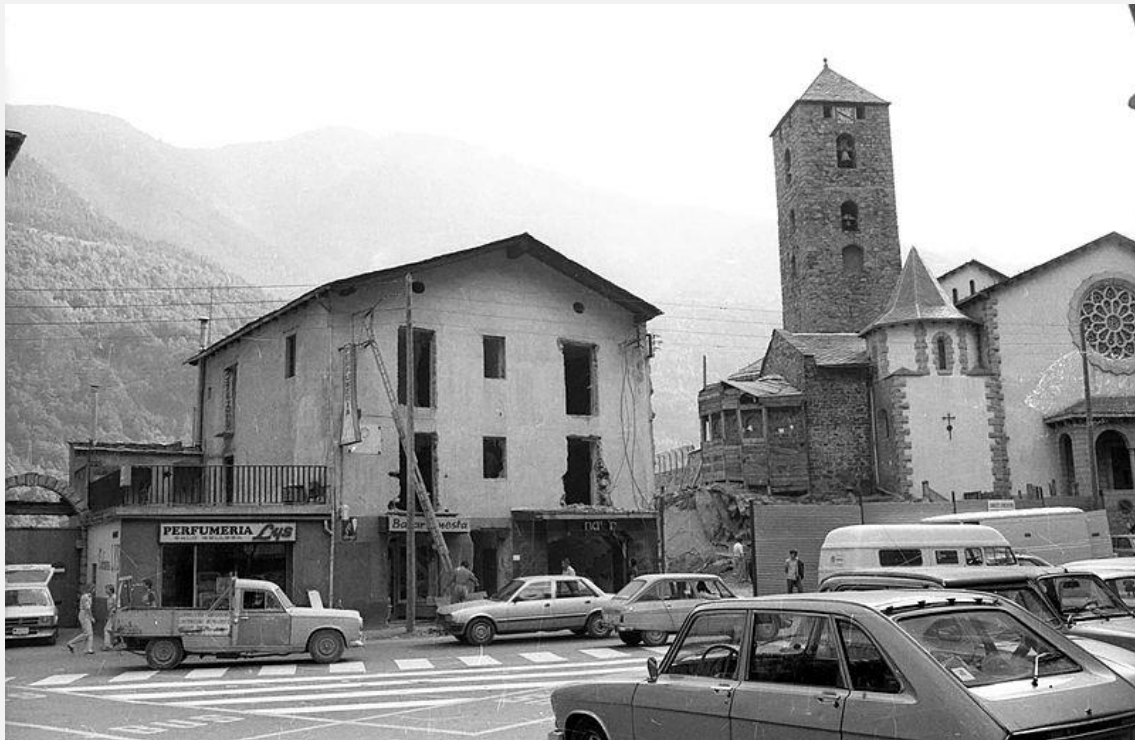
Enderrocament de la Rectoria. Any 1980_Fons Peig_ANA
